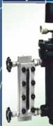
Indicador de nivel para control magnético de nivel para calderas
