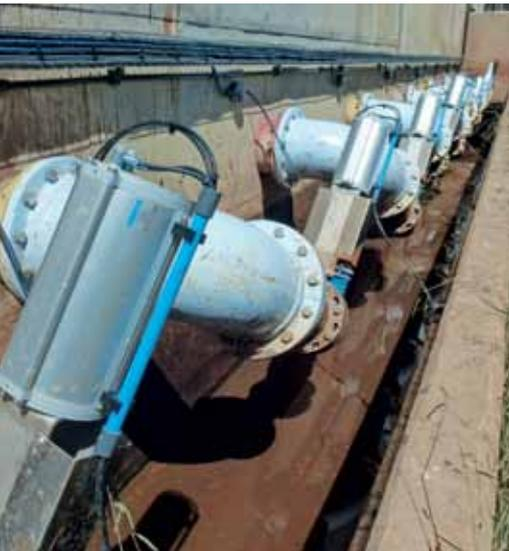
**Abre y cierra los filtros: El robusto actuador giratorio DAPS controla las válvulas de bola y las compuertas de los depósitos de filtración con arena.**
